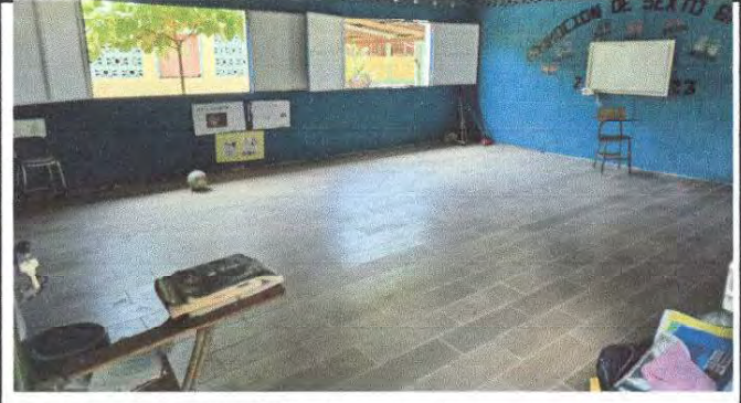
Foto 2: Colocación del 100% del piso ceramico
