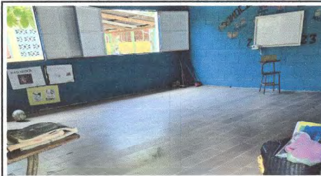
Foto 3: Colocación del 100% del piso ceramico
