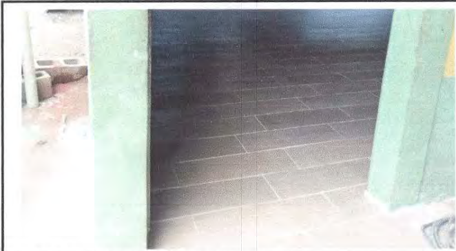
Foto 1: Colocación del 100% del piso ceramico
