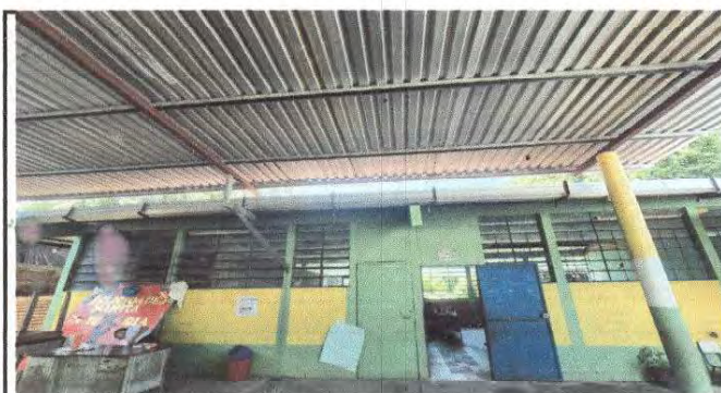
Foto 5: Colocacion final del canal de metal
