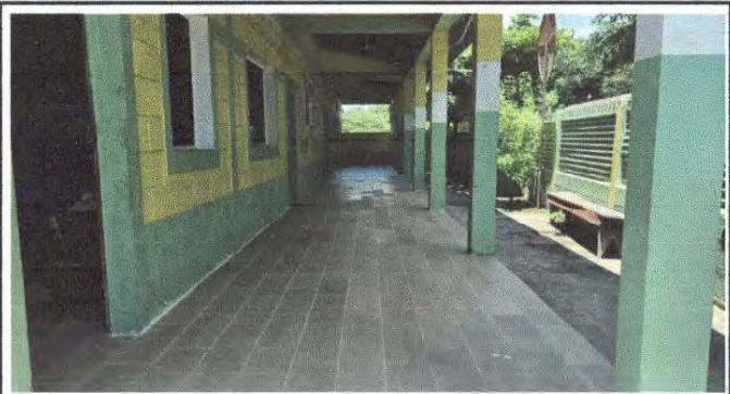
Foto 4: Colocación del 100% del piso ceramico en el corredor
