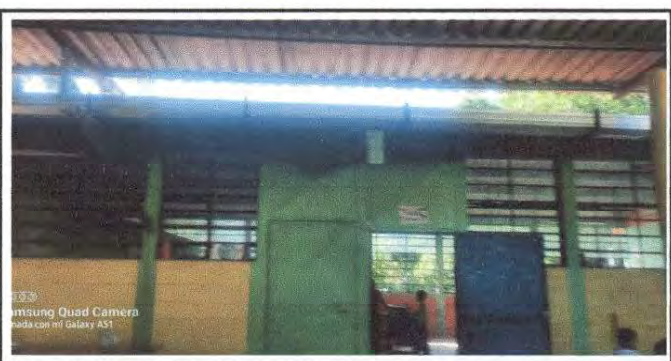
Foto 6: Colocacion final del canal de metal
