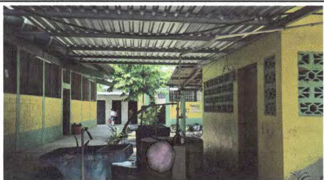
Foto 3: Finalización de colocación de elementos de fijación.
