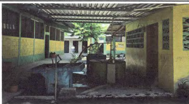
Foto 4: Finalización de colocación de elementos de fijación.
