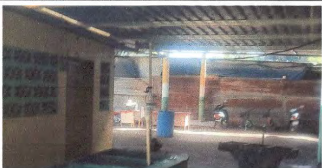
Foto 6: Estructura final del soporte de metal.
