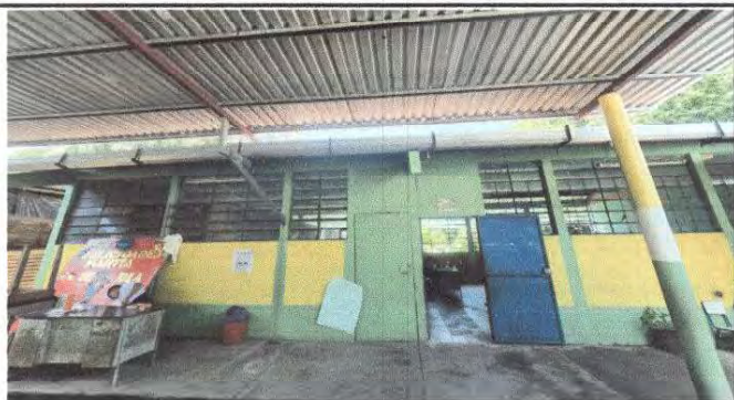
Foto 1: Finalización de la colocación de lamina acanalada aluzinc calibre 26
