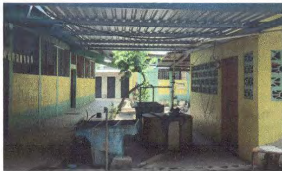
Foto 2: Finalización de la colocación de lamina acanalada aluzinc calibre 26.
