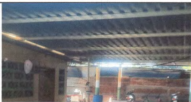
Foto 5: Estructura final del soporte de metal.
